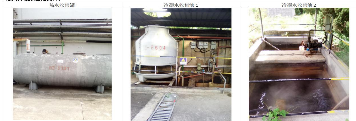
蒸汽冷凝水回用照片：
